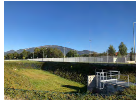
Nelle immagini qui sotto: due esempi di vasche di laminazione a cielo aperto, pavimentazione drenante, greenblock e autobloccanti
